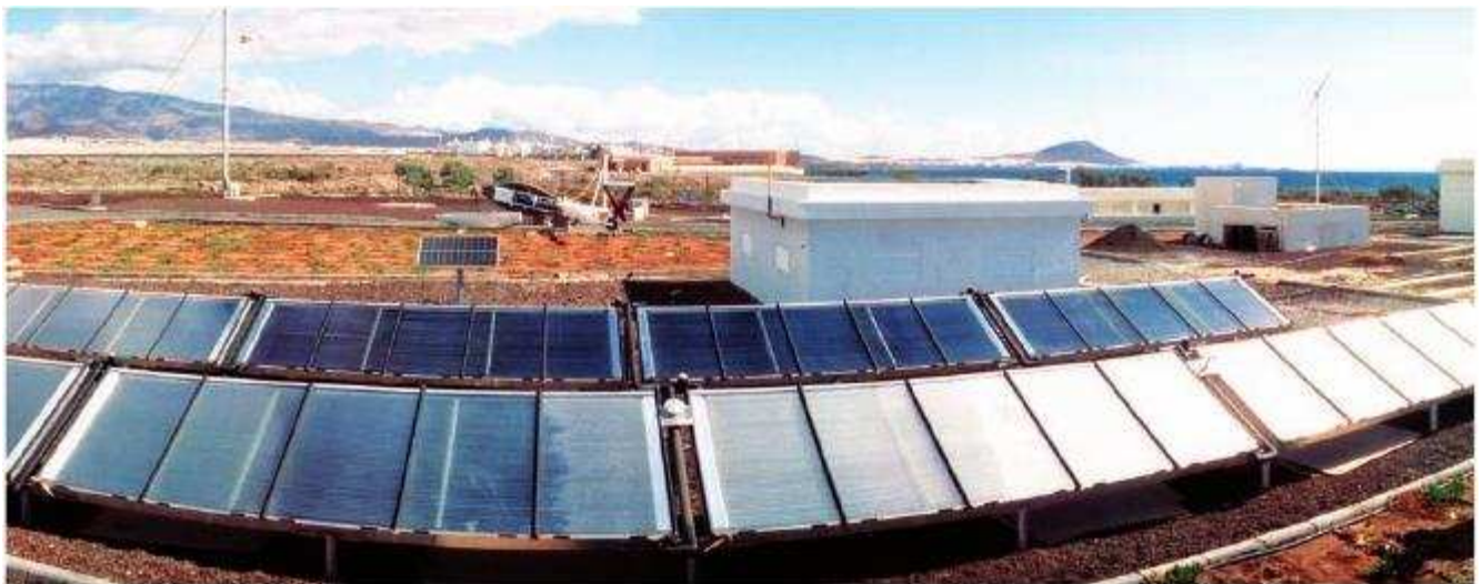
Proyecto de desalación con energía solar térmica en Pozo Izquierdo (Gran Canaria)
