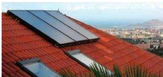
Colector solar integrado en techo
